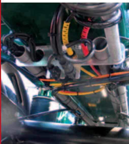
Verrohrung unter dem Kastenträger
