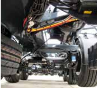
Leitungsbau im hinteren Chassis
