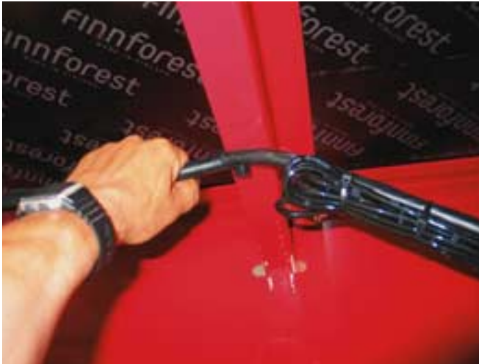
Leitungsverlegung: ohne Befund
