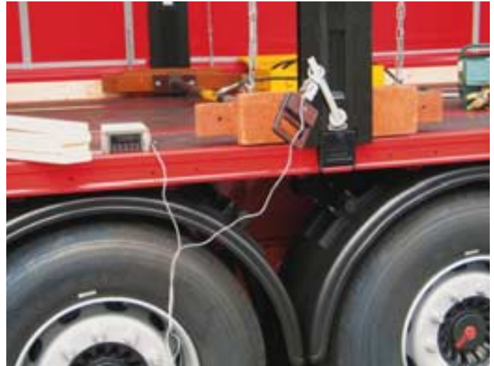
Prüfung am Rungenfuß
