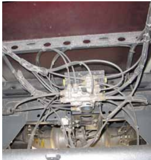
Reichlich unsortiert im Bereich des Modulators
