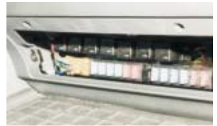
Im Fußraum, Beifahrerseite: die Neben-Elektrozentrale für Anbauten
