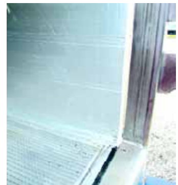
Die kritische Ecke: Bodenauflage, Seiten-Rammschutz und Heckportal
