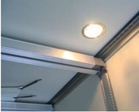
Gekrüpfte Aufnahme: Balken in oberer Position
