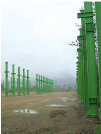
Gebaut wird immer. Pfeiler für das Kesselwerk 2003
