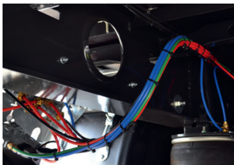
Tadellos: die Leitungsverlegung
