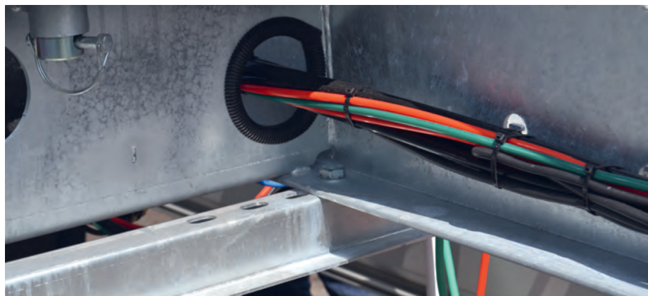
Farblich sortiert, gut geschützt: die vorbildliche Kabellegung durch den Fahrzeugrahmen
