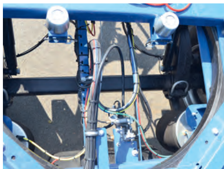
Saubere Sache: die Leitungsverlegung durch das Chassis
